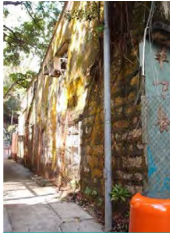
石牆 Stone walls
